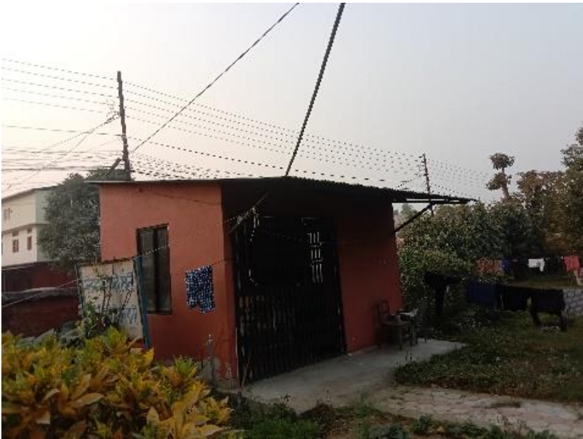
Fig: STORE ROOM
